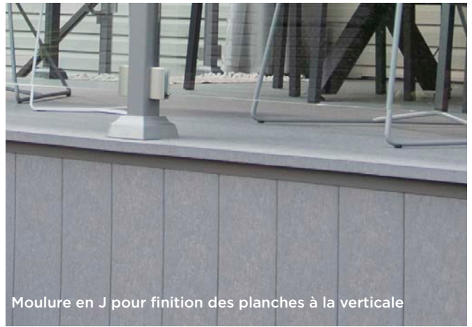
Moulure en J pour finition de contour
